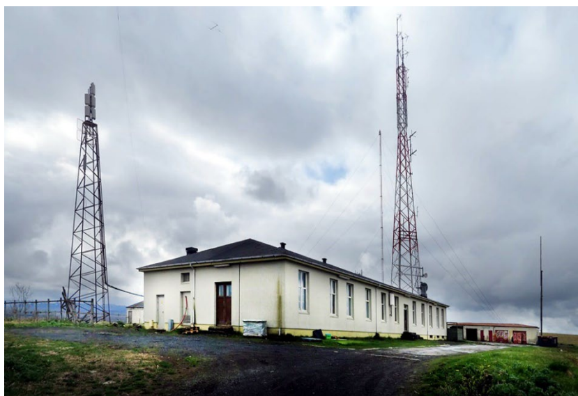
Mynd 4. Mynd af ferlir.is. Útvarpsstöðin sem var staðsett efst á hæðinni en hefur nú verið rifin.
