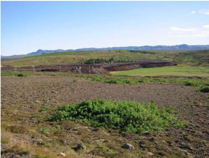
Horft frá Vatnsendavegi í Rjúpnahæð – landfylling á Kjóavöllum
